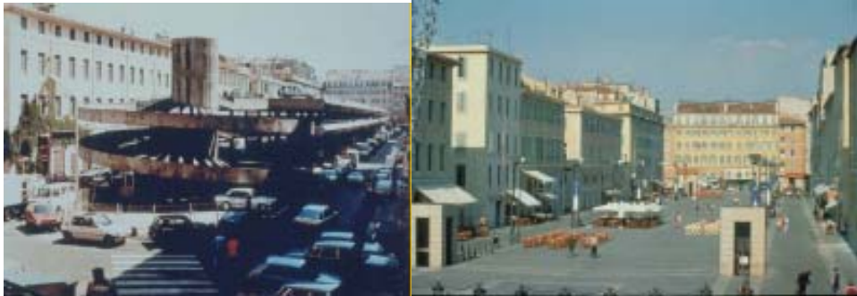
Şekil 10. Marsilya (Fransa) Estienne d'Orves Meydanında 1950 yıllarda yapılan ve mevcut tarihi dokuyla uyumsuz yerüstü otoparkı (solda) yıkılarak yeraltı parkı (sağda) yapılmıştır.
