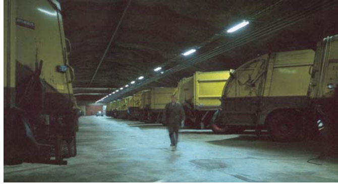
Şekil 8. Stockholm şehir merkezindeki bir parkın altına inşa edilen bu 2 katlı yeraltı yapısı hem çöp kamyonları için otopark hem de transfer istasyonu görevi görmektedir
